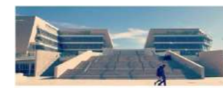
RETTORATO E MACROAREA DI GIURISPRUDENZA SEDE LEGALE - Via Cracovia 50, 00133 Roma
