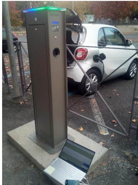
Colonnina di ricarica con n.2 prese T2 da 7,4 kW/cad
